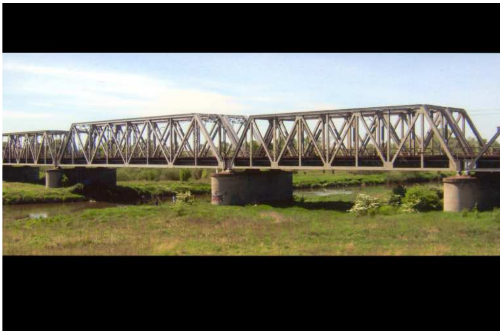
Fot. Most kolejowy na rzece Wiśle w obrębie Babina wsi Gorzów.
