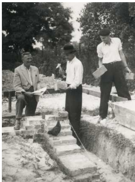
Fot. Pierwsze prace przy budowie szkoły, kierownik szkoły z murarzami.
