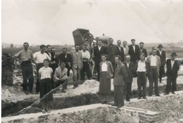
Fot. Wykopy pod nową szkołę.
