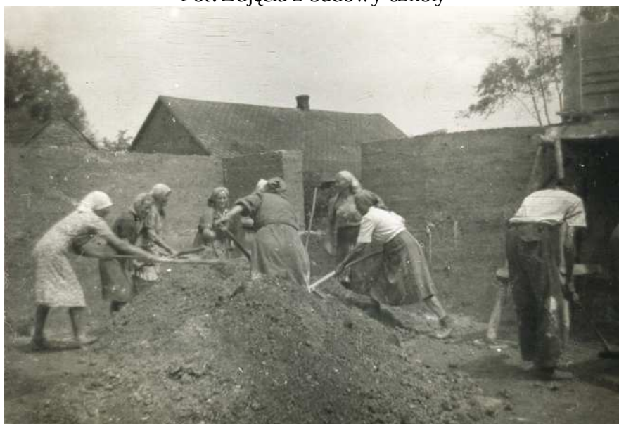
Fot. Zdjęcia z budowy szkoły.
