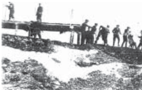
Budowa skoczni na Skale
