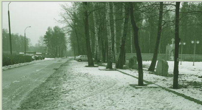
Nowy parking przy ul. Brzozowej (325 m 2 )
