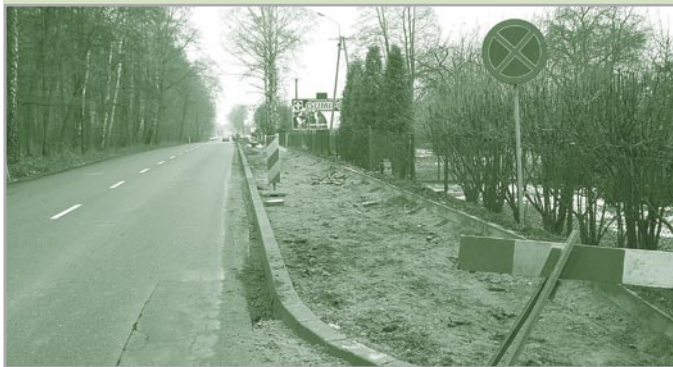
Dokończenie chodnika (200 mb) przy ul. Krakowskiej w Chełmku
