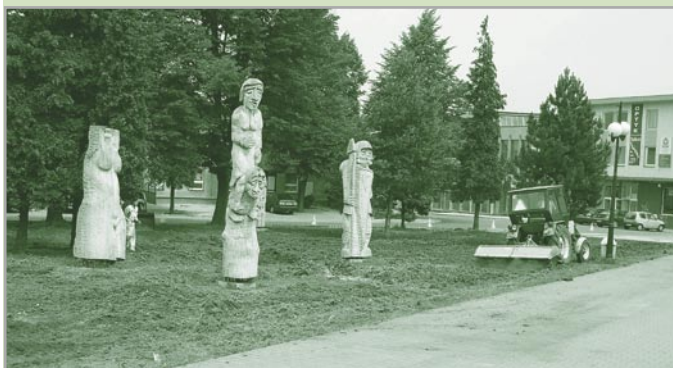
Prace ziemne przy MOKSiR
