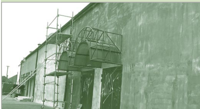
Wykonywanie elewacji na budynku MOKSiR
