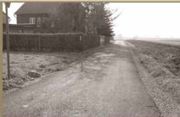
ul. Dębowa w Bobrku. Utrwalenie nawierzchni drogowej emulsją asfaltową o pow. 3 060 m 2 .
