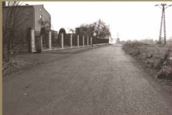
ul. Sportowa w Gorzowie. Wykonanie drogi o nawierzchni asfaltowej grubości 5 cm o pow. 440 m 2 wraz z podbudową grubości 25 cm o pow. 476 m 2 .
