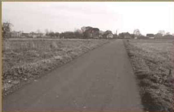
ul. Sportowa w Gorzowie. Wykonanie drogi o nawierzchni asfaltowej grubości 5 cm o pow. 440 m 2 wraz z podbudową grubości 25 cm o pow. 476 m 2 .
