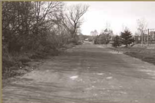
ul. Wrzosowa w Gorzowie. Wykonanie drogi o nawierzchni asfaltowej grubości 5 cm o pow. 650 m 2 wraz z podbudową grubości 25 cm o pow. 513 m 2 .
