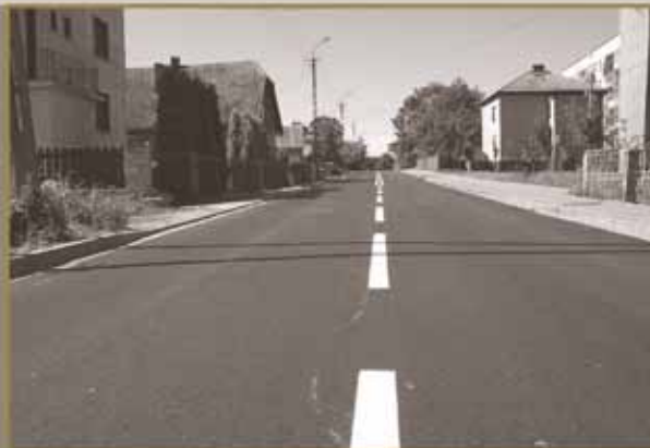
ul. Lipowa w Bobrku. Wykonanie drogi o nawierzchni asfaltowej grubości 5 cm o pow. 120 m 2 wraz z podbudową grubości 25 cm o pow. 140 m 2 .
