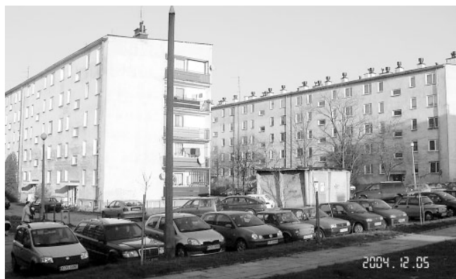
Budynki przy ul. Powstańców Śląskich 2 i 2a, których docieplenie planuje się na 2005 rok.
