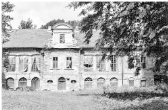
Obecny stan pałacu
