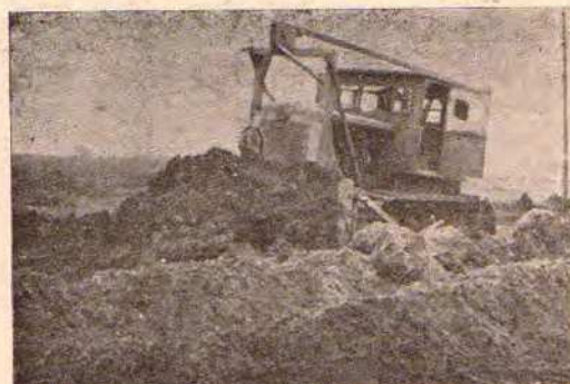
Pracownicy spychacz wyrównał teren pod nowy stadion sportowy i uformował nasyp pod trybunę. Teraz czas na prace wodno-melioracyjne.
