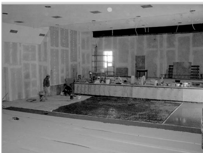
Remontowana sala kinowa
