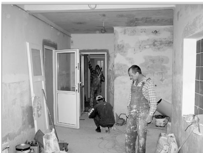
Remont w Domu Ludowym w Chełmku
