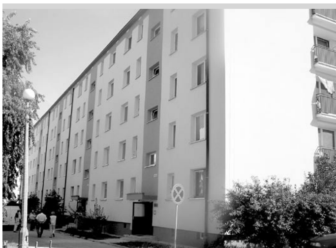
Ocieplanie i nowa elewacja na blokach ADM - u
