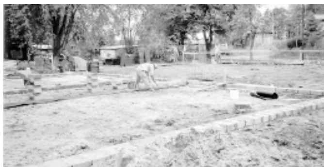
Plac budowy nowej sali gimnastycznej przy SP nr 2 w Chełmku Fot. S. Pędrys-Klisiak
