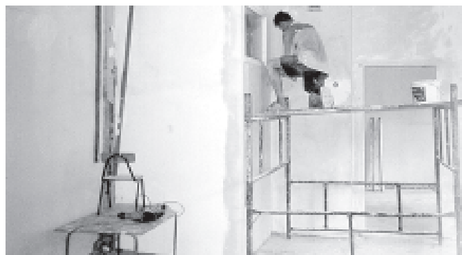
Remont w Przedszkolu nr 1
