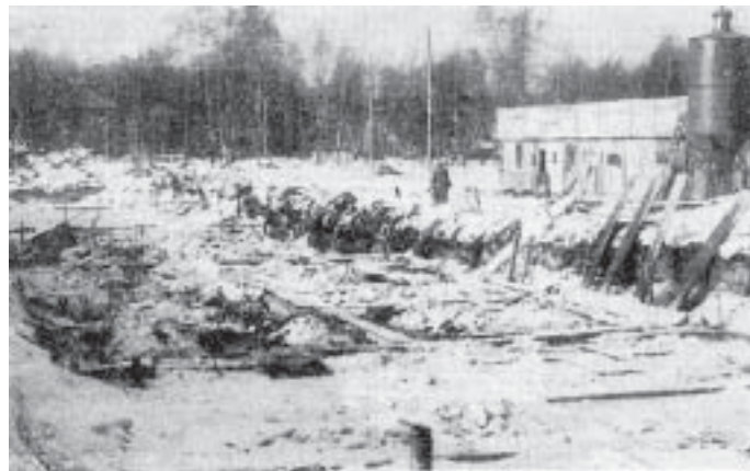
Plac budowy i pierwsze zabudowania fabryki
