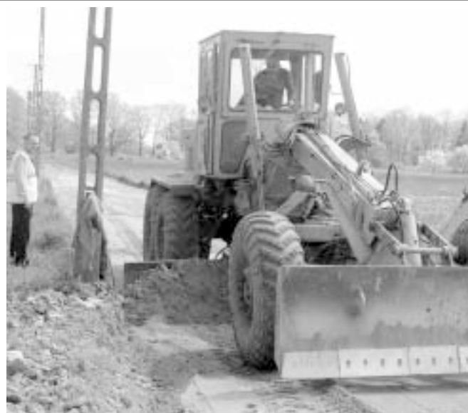
Budowa drogi na ul. Cichej.
