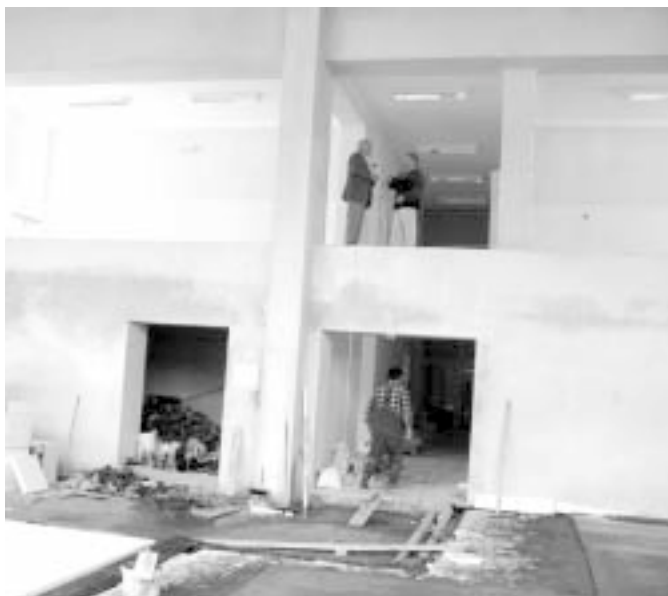
Budowa sali przy SP nr 2
