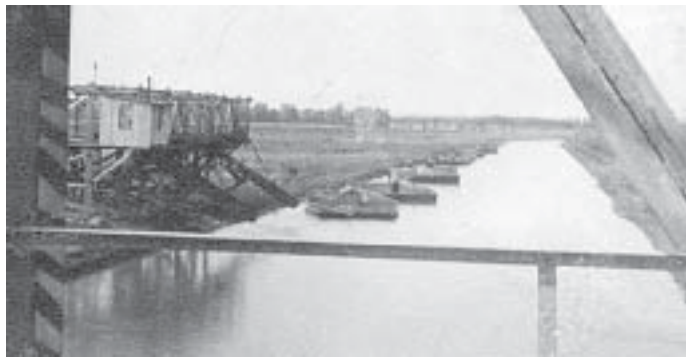
Galary oczekujące na załadunek z ładowni od strony Śląska (zdjęcie wykonane z metalowego mostu)
