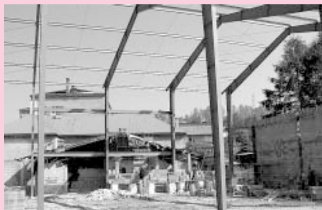
Budowa Sali gimnastycznej przy SP nr 1 w Chełmku
