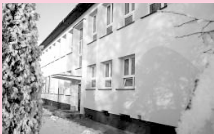
Termomodernizacja i nowa elewacja w SZS w Bobrku
