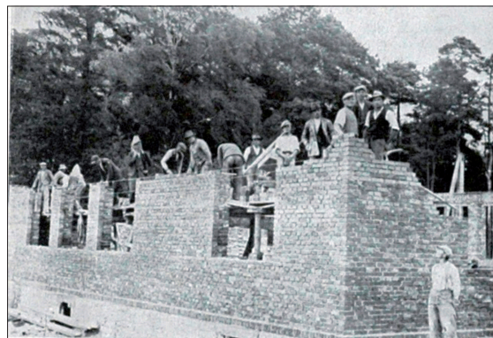
Pracownicy w czasie budowy jednego z domów na Starej Kolonii
