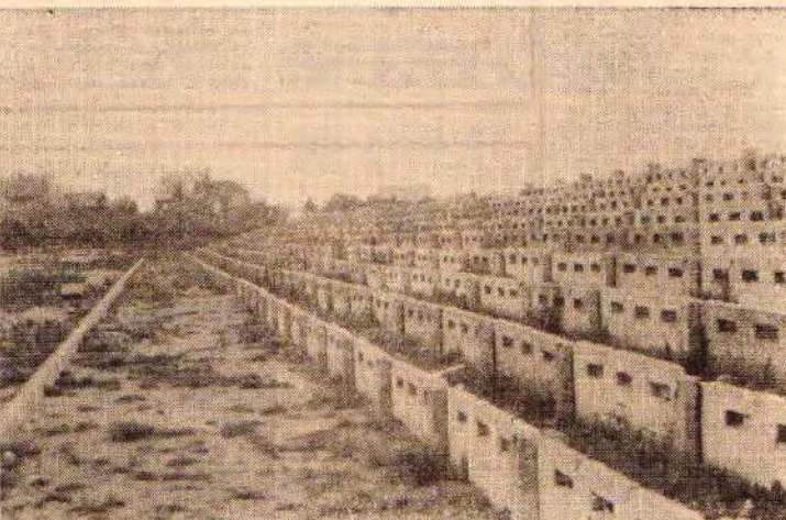
A to już historia — tak wyglądał stadion w czasie budowy
