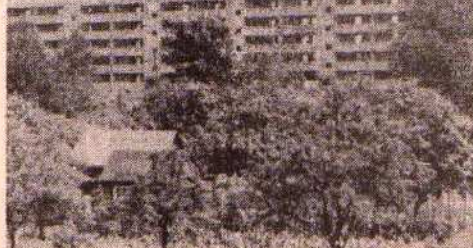
Co pewien czas z satysfakcją publikujemy zdjęcia kolejnych bloków mieszkalnych powstających na osiedlu w Chelme. Ten na zdjęciu budowany jest na licencji NRD. Posiadać będzie 240 izb. Jeszcze w tym roku wprowadzi się do niego 70 lokatorów — członków spółdzielni mieszkaniowej.
