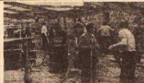
Magazyn? Nie. Garaż? Nie. Kto zgadnie co to za obiekt. To tuczarnia, a właściwie drugi jej budynek, który budujemy z przeznaczaniem na tucz trzody chlewniej, prowadzony przez Spółdzielnię Kółek Rolniczych w Chelme.
