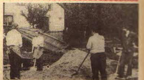
Czyżby krótki przestój w pracy? Chyba nie. Z pełnej gotowości postawy pracujących wynika, że zadrgali tylko na moment, być może, aby wykonać fachowych wskazówek niewidocznych za ścianą szkieletu.
