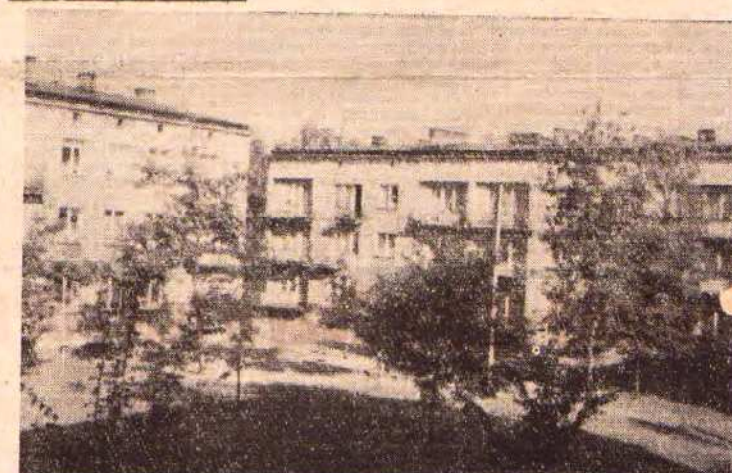
Pięknie po otrzymaniu nowej elewacji prezentują się bloki na osiedlu mieszkaniowym...
