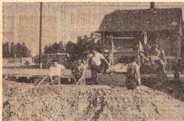
Kółko rolnicze w Chełmku w dalszym ciągu buduje zaplecze na ciągniki i sprzęt towarzyszący. Na zdjęciu betonowanie płyty.
