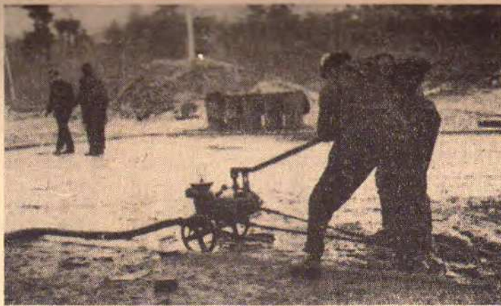
Pompowanie wody z piwnic bloków mieszkalnych na osiedlu w Chełmku
