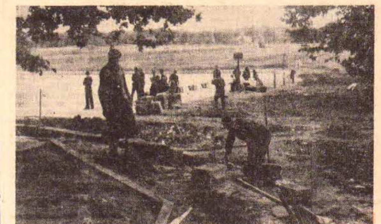
Dobiega końca budowa basenu na Paprotnicy
