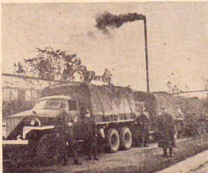
W październiku 1945 r. żołnierze Wojska Polskiego w przejeździe przez Chełmek. W głębi widoczny jeszcze komin starej kottowni fabryki obuwia.
