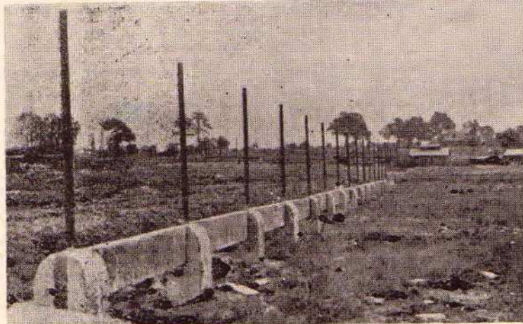
Ogrodzenie, które na tym zdjęciu widać w początkowym stadium jego budowy, jest już prawie całkowicie wykończone
