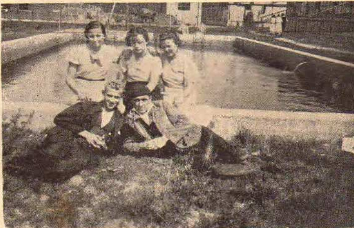
Nasi współpracownicy nad nowowybudowanym basenem przy naszych zakładach.
