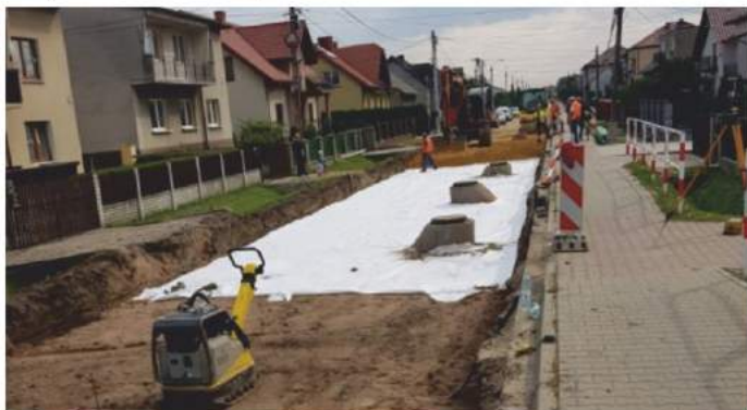
Budowa kanalizacji w ul. Nadwiślańskiej w Bobrku
