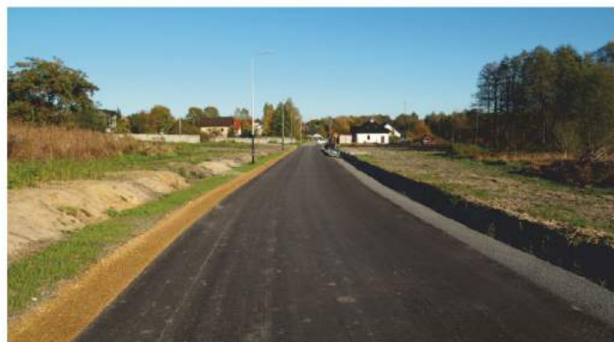
Wybudowana ul. Brzechwy w Chełmku
