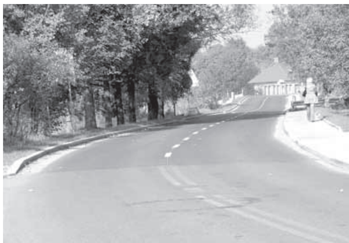
Zmodernizowana droga powiatowa - ul. Jaworznicka w Chełmku
