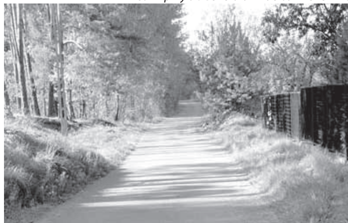
Nowa nawierzchnia przy ul. Wrzosowej w Chełmku
