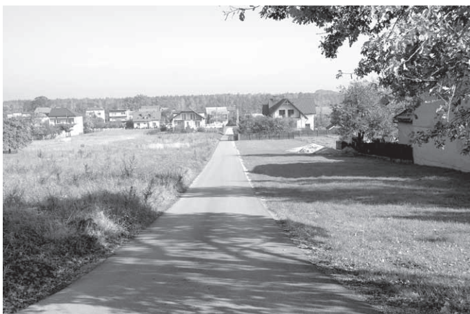
Nowa nawierzchnia przy ul. Sienkiewicza w Chełmku
